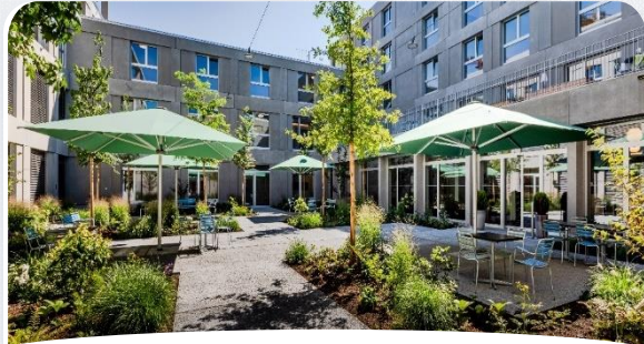
Casa Giesserei Arbon (Thurgau)
